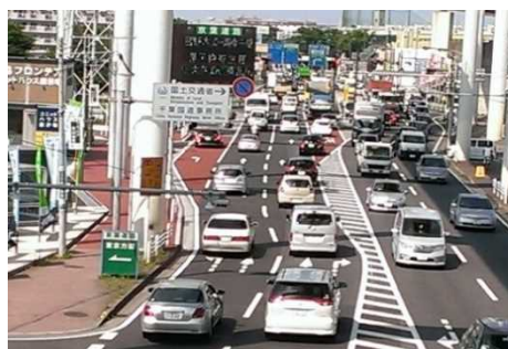
千葉中環状道路(国道126号)
