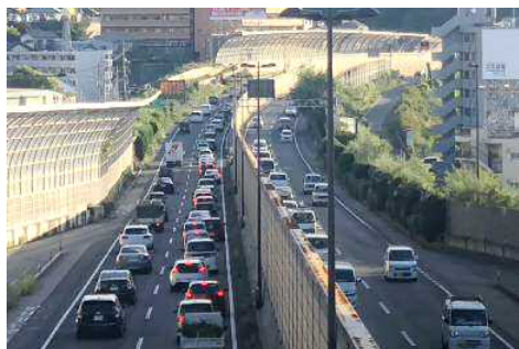
広島西道路(一般国道2号西広島バイパス)
