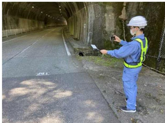
目視により路面性状を確認
