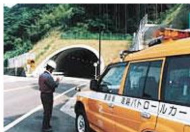
現地状況を目視確認
