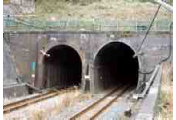
東海道線 保土ヶ谷・東戸塚間 清水谷戸トンネル 取得年 1887年[経年132年]
