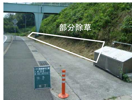
通行支障箇所のみ除草
