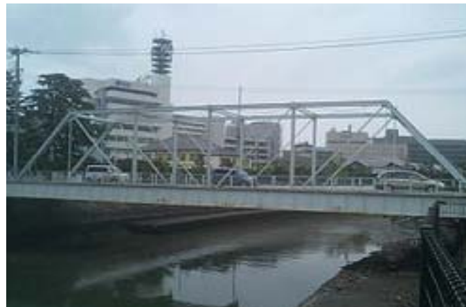
出島橋（長崎県長崎市） 1910(明治43)年架設（約102年経過）
