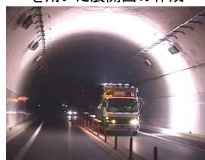
CCDカメラによる画像 を用いた展開図の作成
