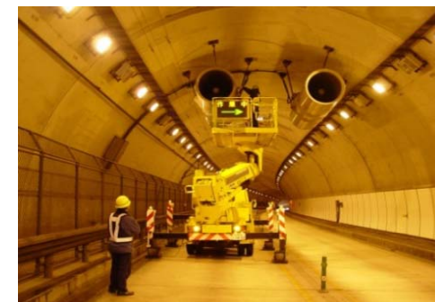
トンネルジェットファンの点検状況
