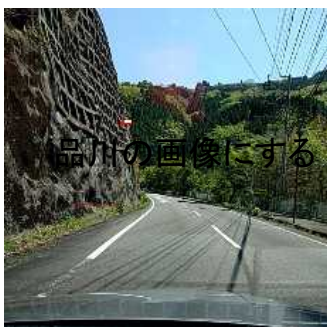
落石防止壁をポットホールと誤判定
