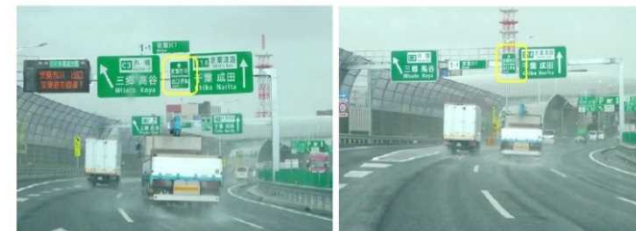
京葉JCT分岐標識への補助標識追加(行動点、分岐点)
