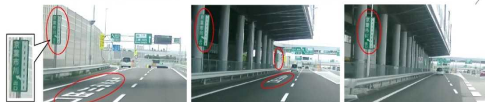
路面表示×2箇所、補助標識設置×4箇所 (京葉道路(上)の京葉市川出口誤進入対策)
