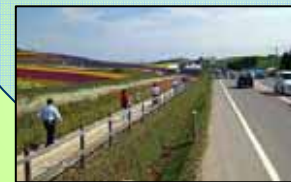
電柱の片寄せ
