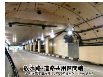
貯水機能を有した放水路トンネルと交通渋滞緩和のための道路トンネルを併用
