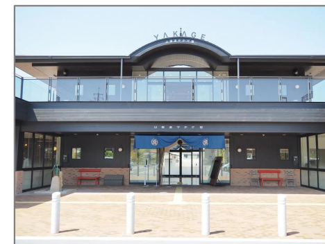
道の駅「山陽道やかげ宿」外観
