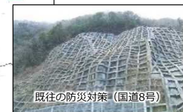
既往の防災対策（国道8号）
