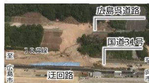
広島県道路・国道31号の被害状況
