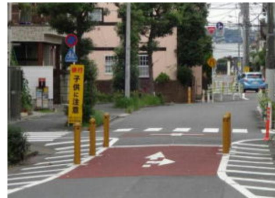
<生活道路における狭さく部整備例> (国交省資料より抜粋)
