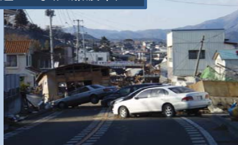
国道45号(大船渡市)
