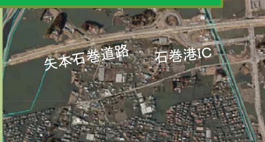
三陸縦貫道(矢本石巻道路)
