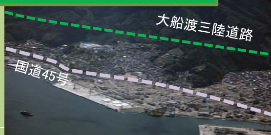
三陸縦貫道(大船渡三陸道路)
