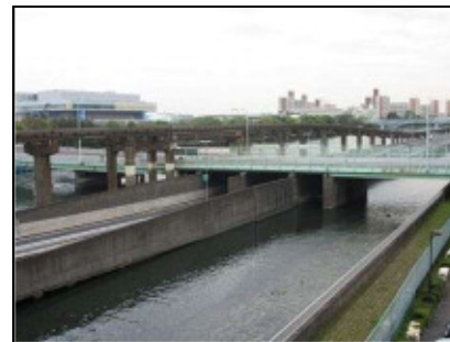
① 都道421号(大井埠頭橋)
