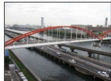
② 大井水管橋
