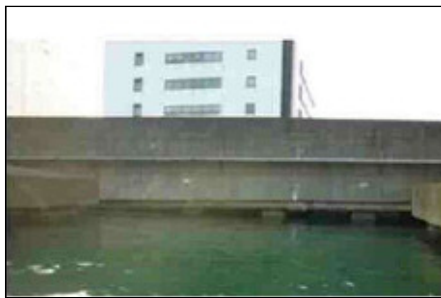
海水面に最も近接している箇所(大井ふ頭付近)
