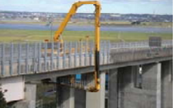
(参考)現在の橋梁点検車を使用した点検
