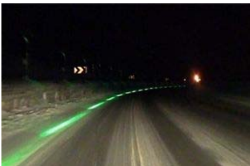
【新技術】レーザーによる路肩表示
