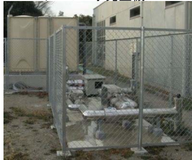
ナノバブル(数100nmの微細泡)水による節水型トイレ洗浄事例
