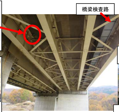
ジンボールからのRC床版下面の撮影画像
