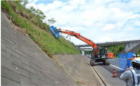
のり面草刈の機械化による作業軽減とコスト削減事例
