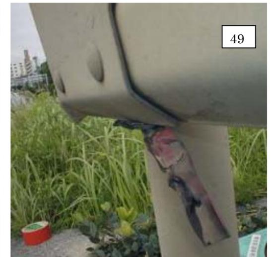
4. 金属片に塗料がないもので、防護柵に衝突の痕跡があるもの（写真右肩の数字は材料分析通し番号）
