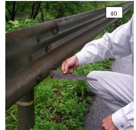
5. 金属片に塗料がないもので、防護柵に衝突の痕跡がないもの（写真右肩の数字は材料分析通し番号）
