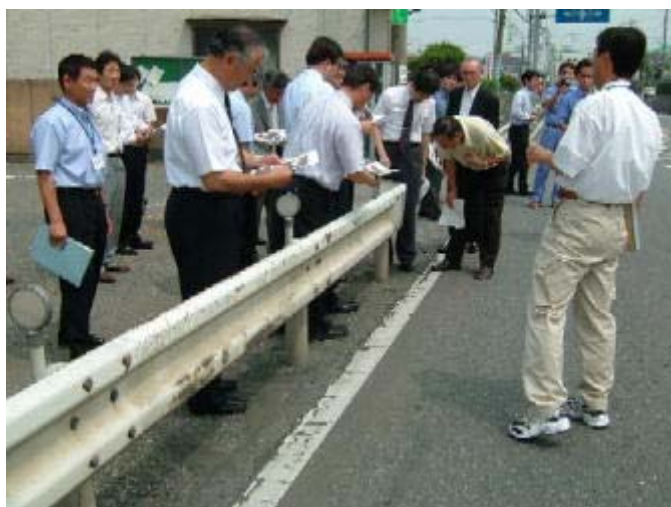
写真 4 - 1 現地調査の様子
