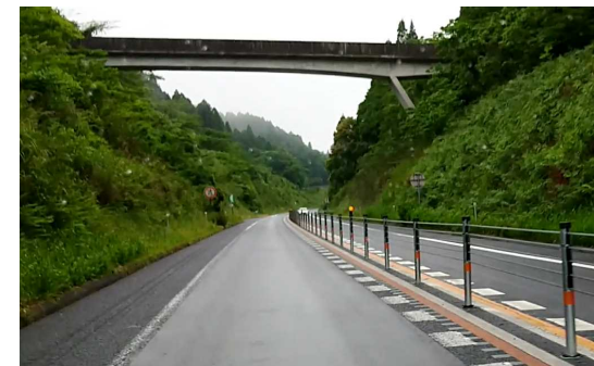
飛出し箇所の状況(復旧後)
