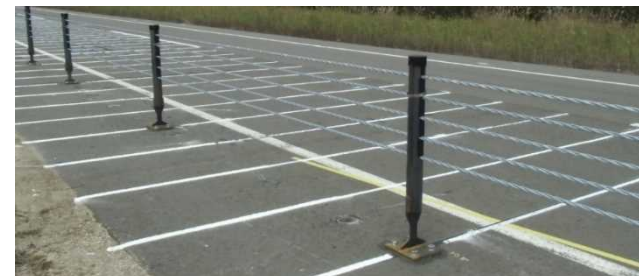
設置写真(衝突実験時)
