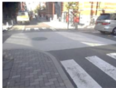
図 4-17 薄層カラー舗装および小舗石舗装
