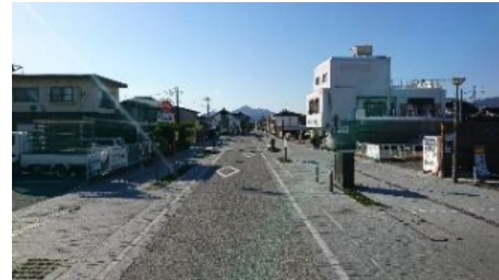
歩道の石張り舗装を車道の路肩まで敷設
