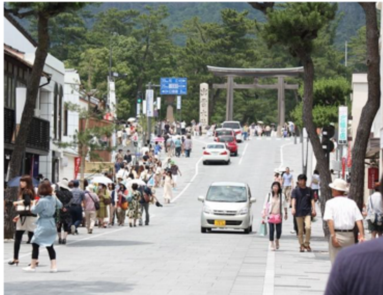
歩行空間の石張り舗装を車道へにじみ出し
