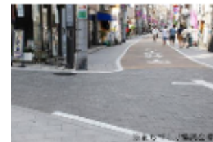
交差点部のブロック舗装 (イメージハンプ)
