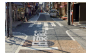
交差点部のブロック舗装 (イメージハンプ)
