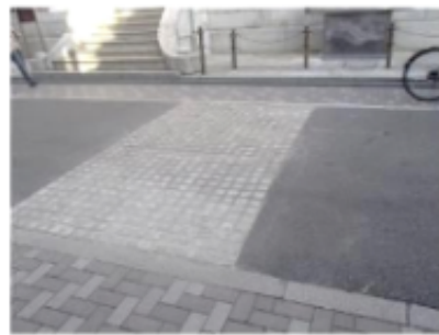
図 4-17 薄層カラー舗装および小舗石舗装
