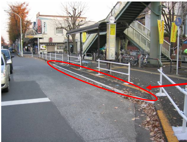
写真4 切り込みテラス型バスベイの例
