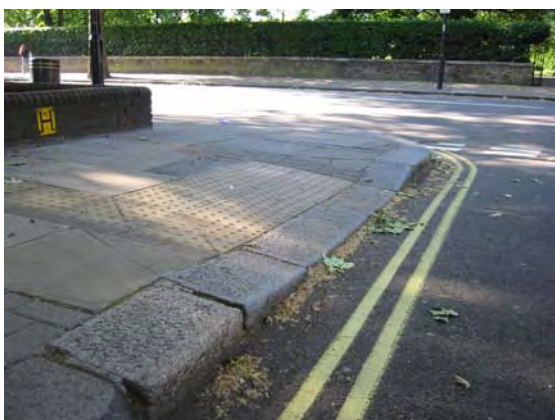
ロンドン:横断部全体が切り下げられており、2~3cmの段差がある。
