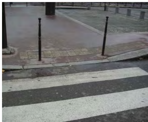
パリ:横断部全体が切り下げられており、ほとんど段差がない。
