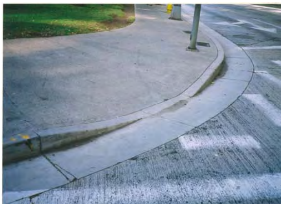
ハワイ:横断部の一部が切り下げられており擦り付け部分の段差はほとんどない。
