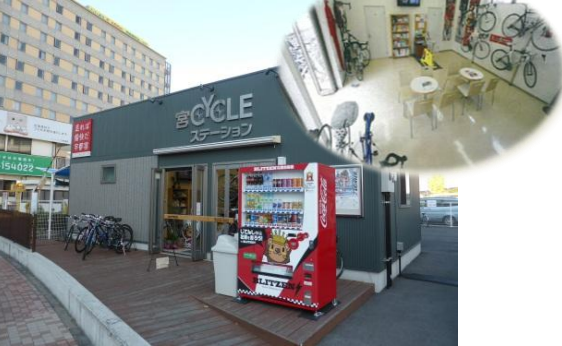
休憩、自転車修繕、シャワー施設、スポーツバイクのレンタル等を行う「モビリティセンター」を設置
