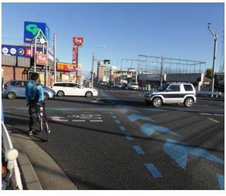
交差点内へのピクト・二段階右折スペースの設置
