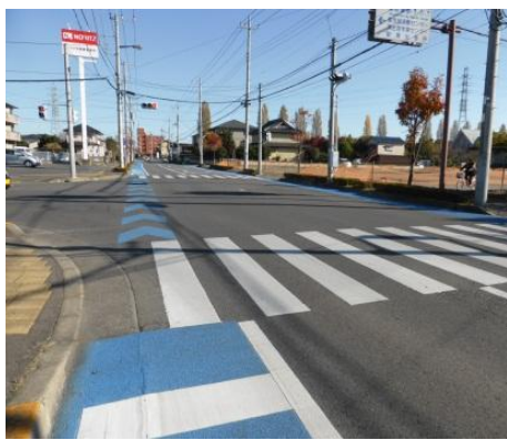
自転車専用通行帯、停止線の前出し
