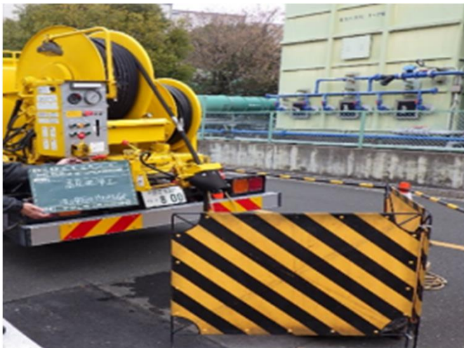
① 管路内高圧洗浄作業
