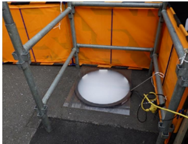
② 臭気漏洩等試験
