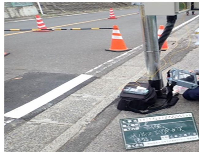
④ 通信ケーブル伝送試験
