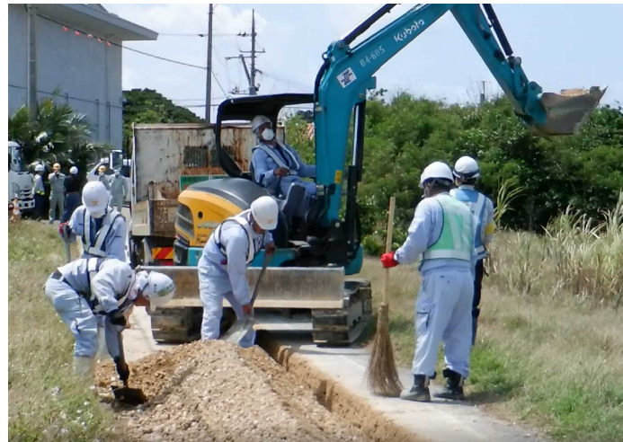
▲排土処理状況(バックホウ+人力)
