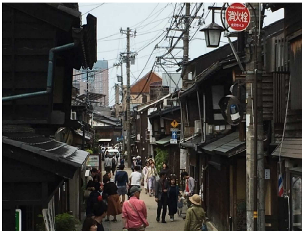
【石川県金沢市】 風情ある伝統的建造物群にそぐわない電柱・電線。
