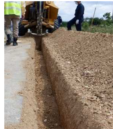
▲掘削堀山の状況
