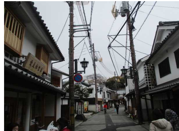
【岡山県倉敷市】 景観法に基づく景観地区に張り巡らされる電線。
