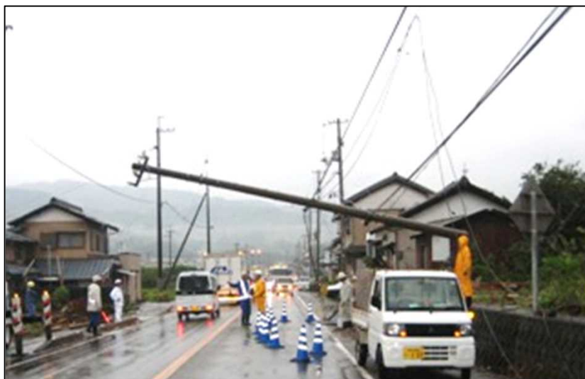
国道55号 高知県安芸市
