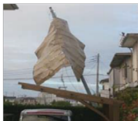
<飛来物による電柱倒壊（東金市）>
