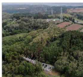
<鉄塔の倒壊（君津市）>
