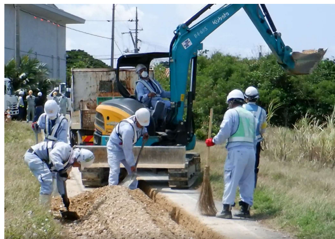
▲排土処理状況(バックホウ+人力)
