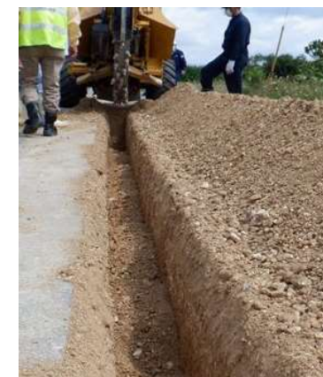
▲掘削堀山の状況
