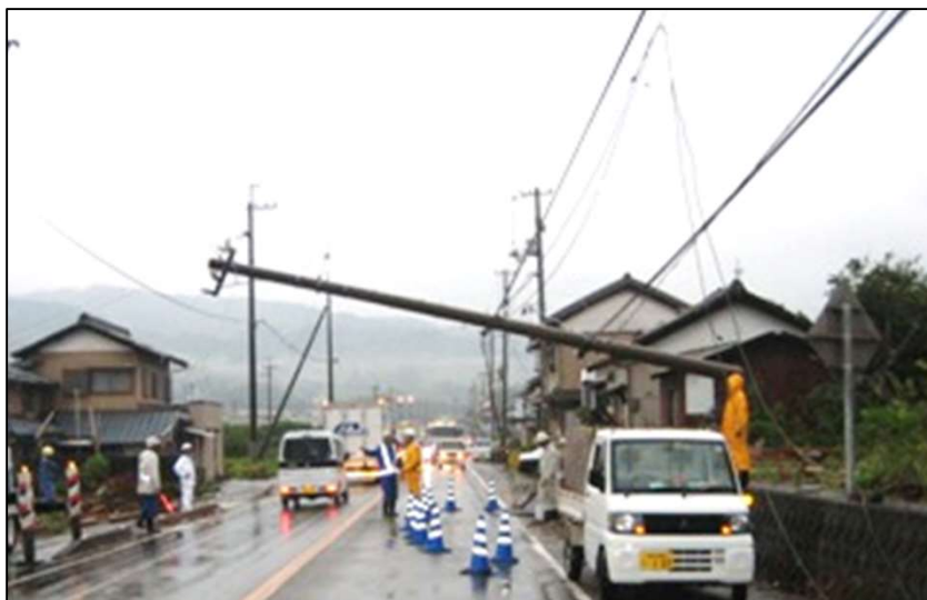
国道55号 高知県安芸市
