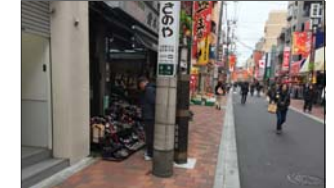
【歩道整備事業において、電柱が歩道上に残った事例】
