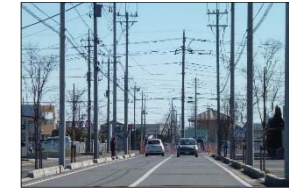
【土地区画整理事業において、新たに電柱が設置された事例】
