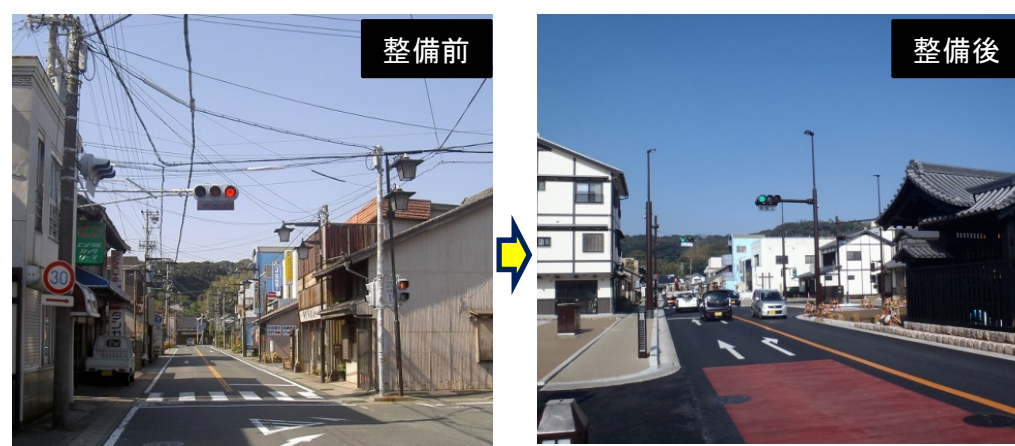
静岡県湖西市(国道301号歩道整備)
