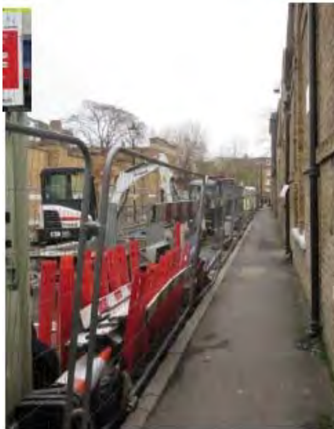
ロンドンの開削工事現場の様子 （経済産業省 海外調査資料より）
