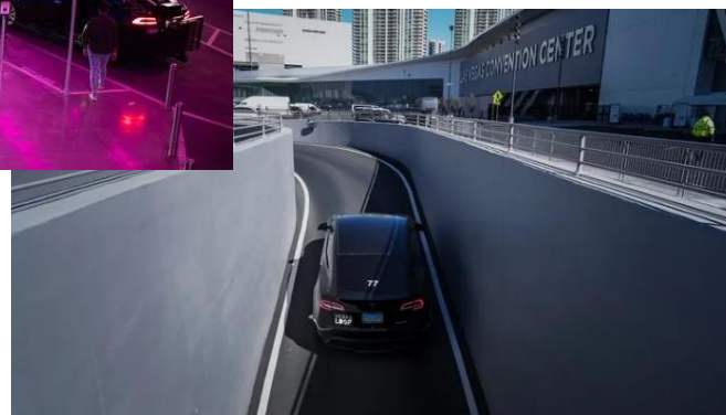
地上駅手前での地下から地上への出口
