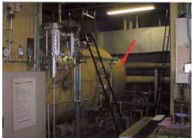
石綿含有保温材 (ボイラ外周部)
