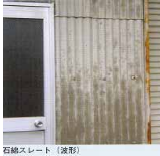
石綿スレート (波形)
