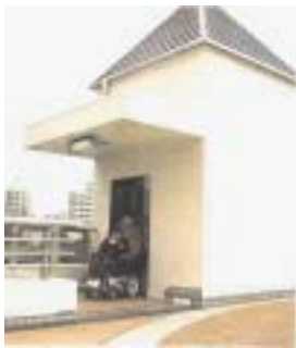
図8-9 歩道橋でのエレベーター設置
