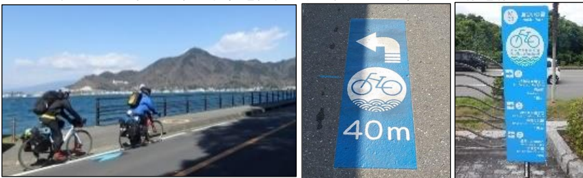
路面表示（矢羽根）の設置
