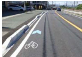
(矢羽根型路面表示設置箇所の状況)
