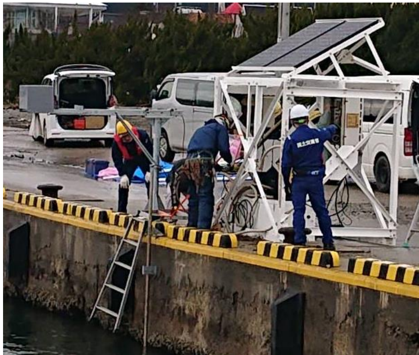
①設置作業の様子(左:筐体の積み下ろし、右:電源部作業)
