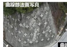
曲線部法面写真
