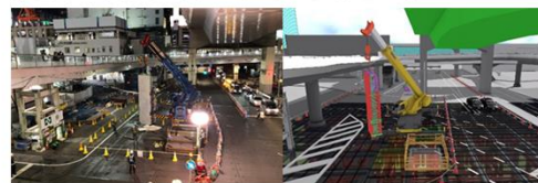
施工状況とシミュレーション
