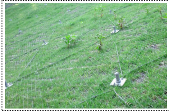
写真一 1 施工例
