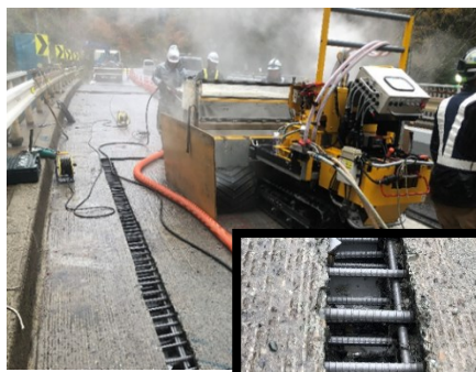
写真-2 施工状況（左：床板補修工事 中：床板部分打替、縁切工事 右：床板拡幅工に伴うはつり工事）
