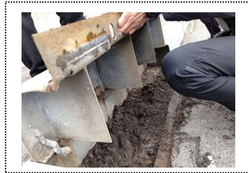
写真四 従来の鋼製排水溝内部
