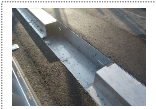
写真三 鋼製排水溝内部状態
