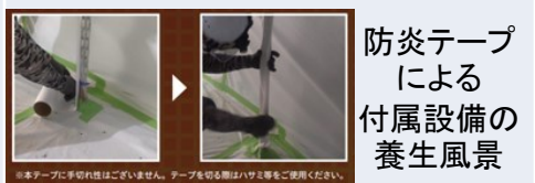
防災テープによる 付属設備の 養生風景
