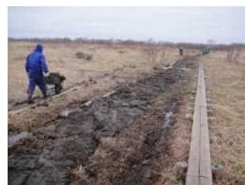
水抜き水路の埋め戻し
