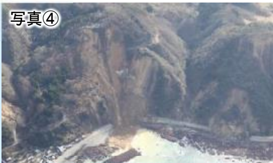
国道249号法面崩落
