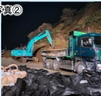
国道249号作業状況
