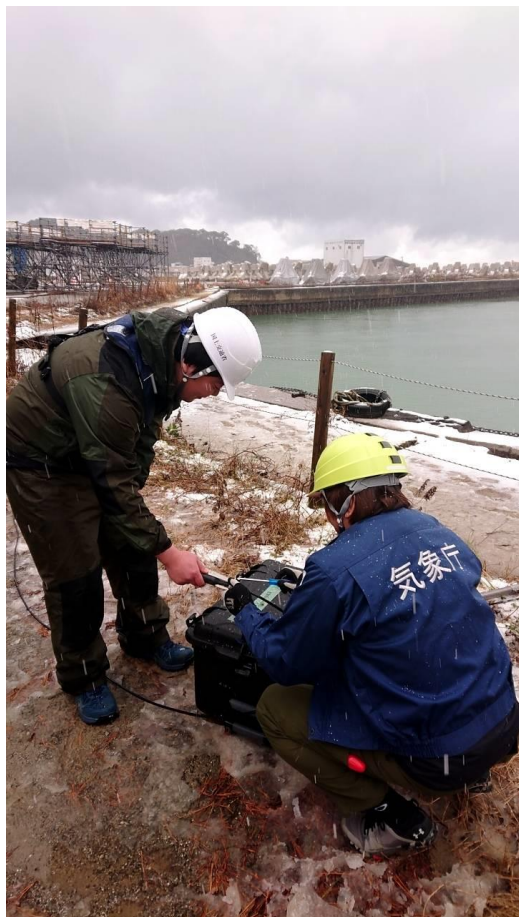
①組立作業の様子
