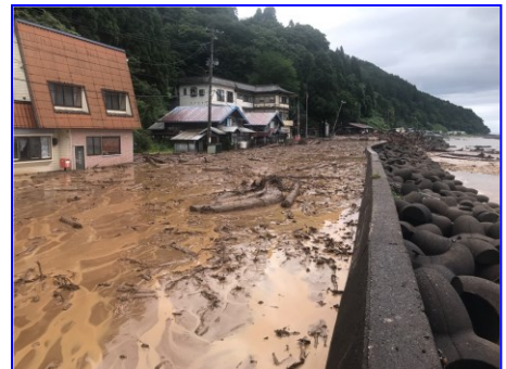
土石流の状況 そとがはま たいらだて （青森県外ヶ浜町平 館）
