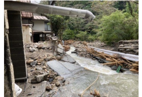
静岡県静岡市葵区油山で発生した土石流等 （静岡県静岡市）
