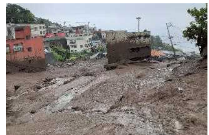
土石流による被害（静岡県熱海市）
