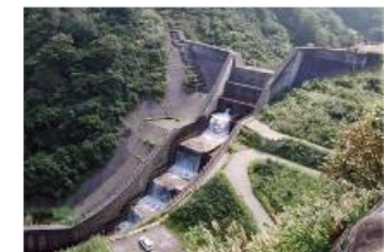
砂防施設(砂防堰堤)
