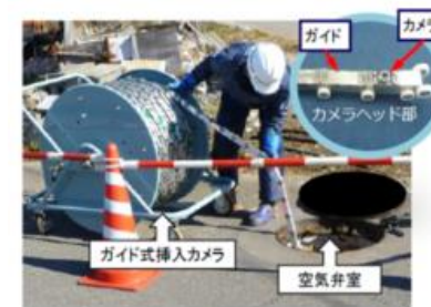
ガイド挿入式カメラを使った調査風景
