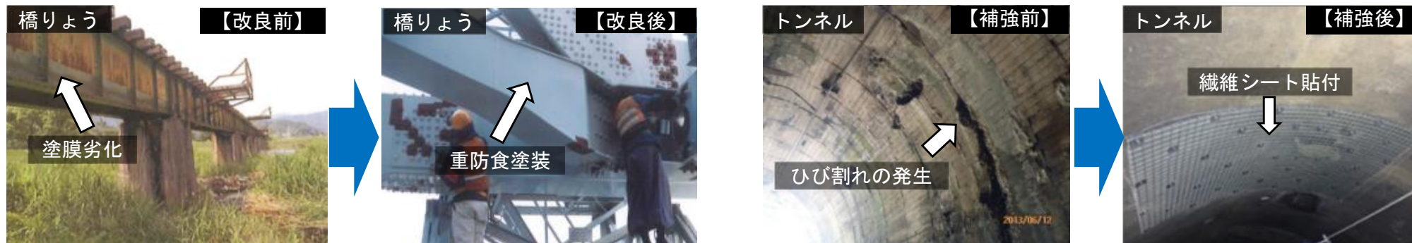
【橋りょう、トンネルの長寿命化に資する改良・補強事例】
