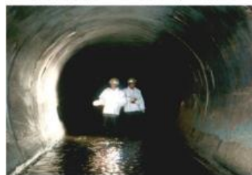
・潜行目視による点検・調査
