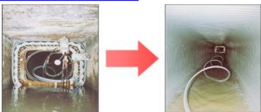
部分取替による長寿命化
