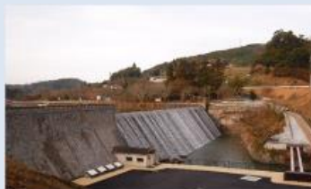
工事完了全景写真 (景観を保持)
