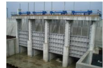
海岸保全施設(水門)
