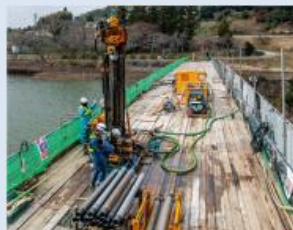
堤体PSアンカー施工状況
