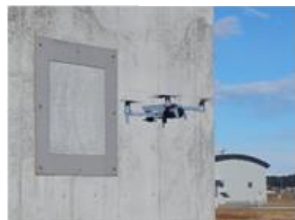
ドローンによる損傷把握
