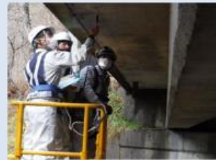
現地点検の実施状況
