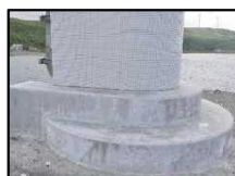
基礎部亀裂補修 (環境遮断)
