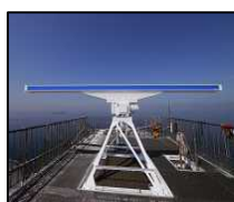
レーダーの整備
