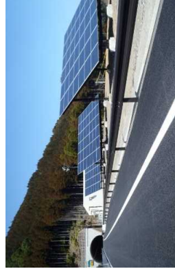
太陽光発電施設の設置(イメージ)
