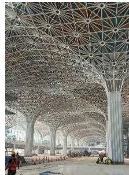
■ 新国際線ターミナル整備の状況 (2023年8月31日)
